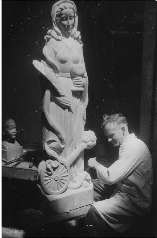
Frühwerk / St.Barbara Artilleriekaserne / Corumba, Portugal
